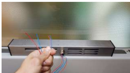
Mit der Verkabelung fortfahren
