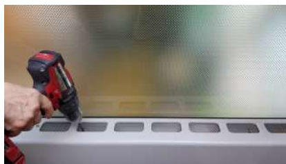
Utilisateur 1 : Percer le grillage micro-perforé au niveau des marques
