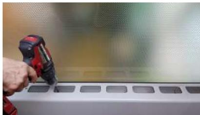
Usuario 1: Perforar la red microperforada en correspondencia de las señales.
