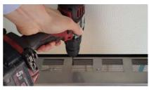
Benutzer 1: An den Markierungen, Löcher in das mikroperforierte Gewebe bohren.
