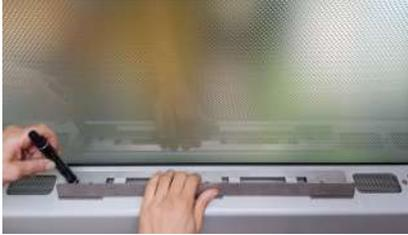
Benutzer 1: Die Gegenplatte von innen auflegen und die Bohrungen mit einem Filzstift markieren.
