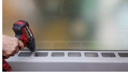
Benutzer 1: An den Markierungen, Löcher in das mikroperforierte Gewebe bohren.
